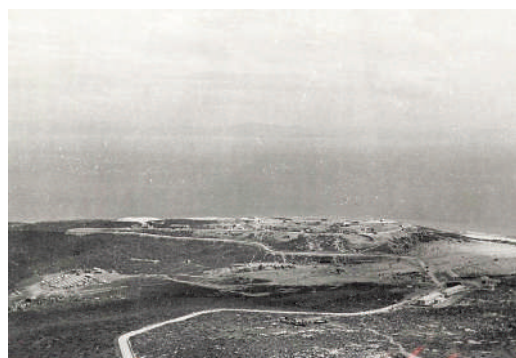
COSTA. Obras y caminos en la costa de Tarifa. África al fondo.
